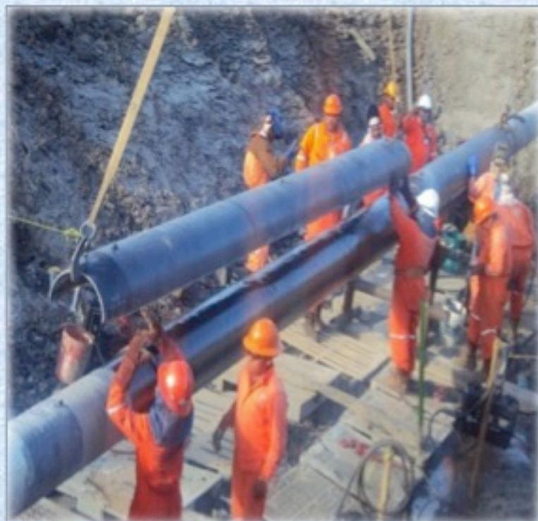
PARA REPARACIÓN DE FALLAS DE INTEGRIDAD GRAVES; ENCAPSULADO DE VÁLVULAS O ACCESORIOS CON FALLA COMO SON: GRAPAS, SPLIT SLEEVES, COMPOSITE WRAPS, ETC. INSTALADOS EN CODOS, SECCIONES RECTAS O EN 'T', CURVAS; ABOLLADURAS, GRIETAS CON/SIN FUGA O ARREGLOS ÚNICOS Y/O DIFÍCILES DE ACCEDER
