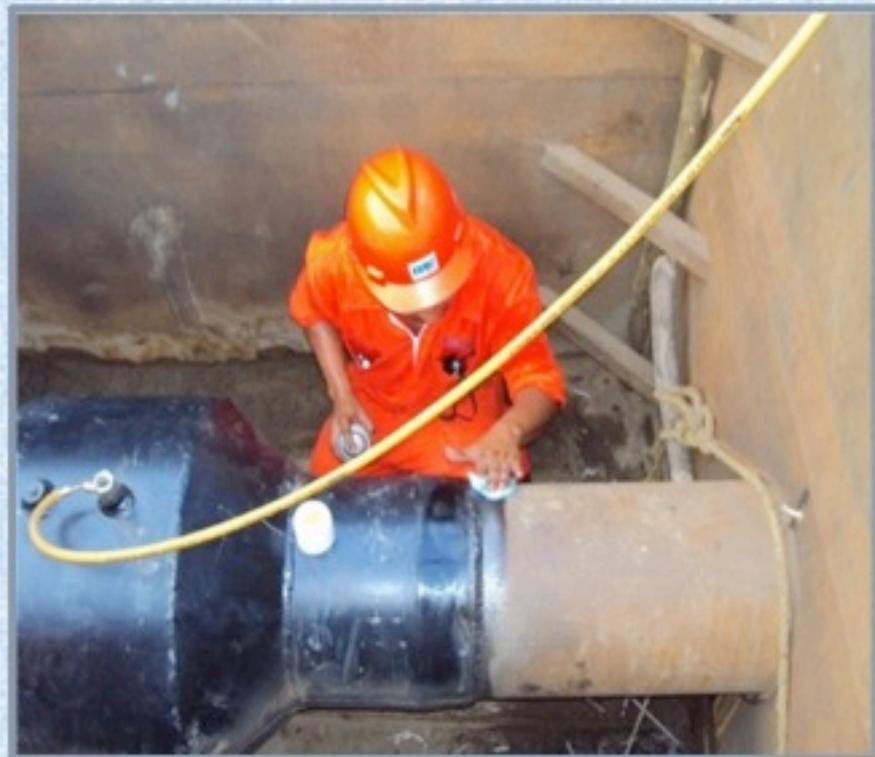
DISEÑOS ESPECIALES CON REDUCCIÓN/AMPLIACIÓN DE ACUERDO A LA GEOMETRÍA DEL PUNTO A REFORZAR. ESPACIO ANULAR SATURADO A PRESIÓN CON RESINA INCOMPRESIBLE **RAMFILL-INYECCIÓN**
